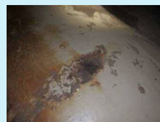
下部工(補修前)
