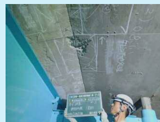
床版(補修・補強前)
