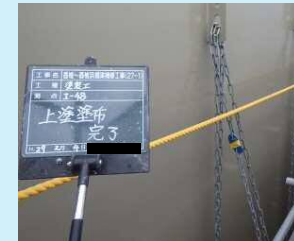
下部工(補修後)
