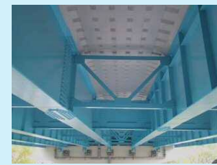
床版(補修・補強後)
