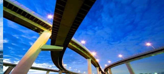
りんくうJCT(関西空港自動車道)西日本高速道路株式会社
