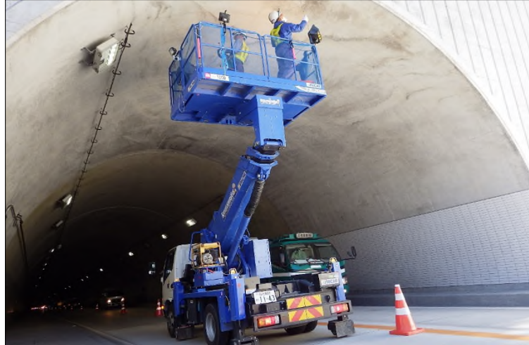
トンネルの点検
