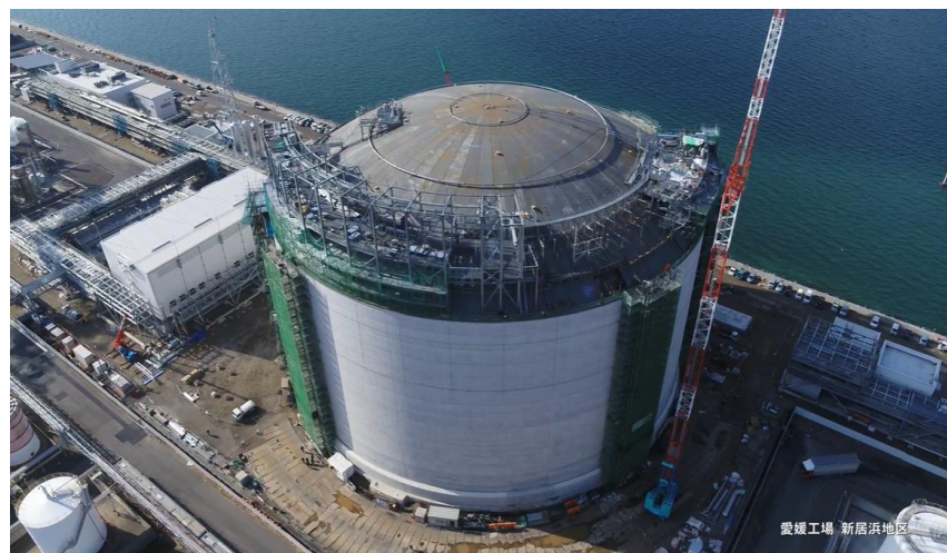
愛媛工場敷地内に、国内最大級のLNGタンクを建設中
